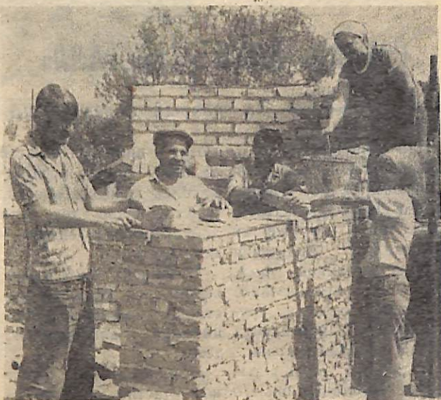
В совхозе «Балтрабочий» развернулось строительство детского сада на 140 мест. Возводит объект комплексная бригада Курской МПМК Агропромстроя, возглавляемая опытным бригадиром Н. В. Макеевым.
