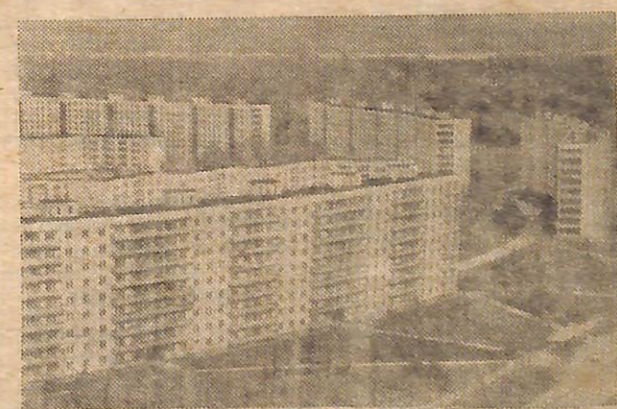
«Сибкадемстрой» уже возведи первую очередь нового города, строительство второй очереди продолжается. НА СНИМКАХ: лауреаты Государственной пре-
