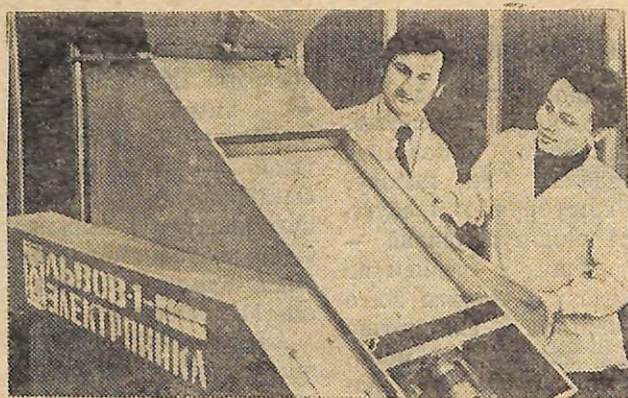
Серийный выпуск установок для предпосевного лазерного облучения семян «Львов-1
