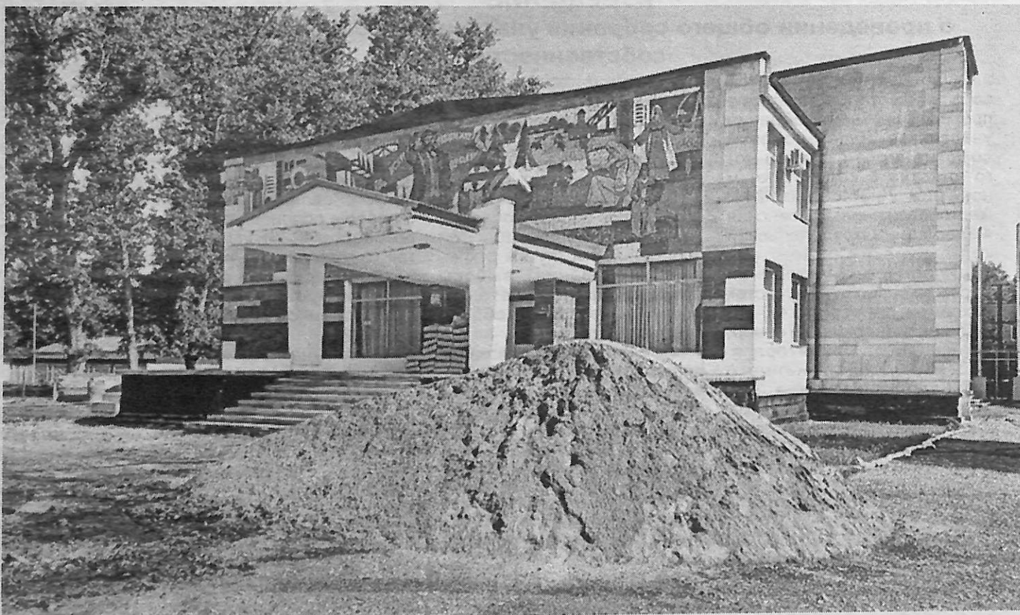
Идут работы на территории, прилегающей к Мирненскому СДК.
