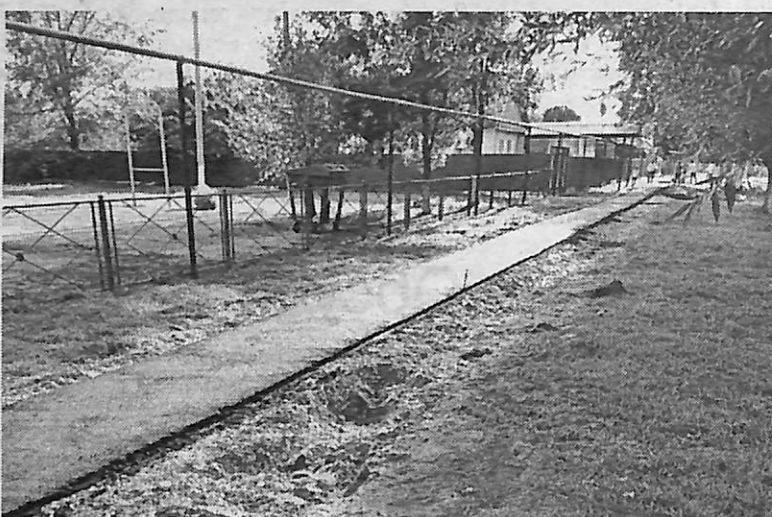
Новая тротуарная дорожка в х. Зайцево.
