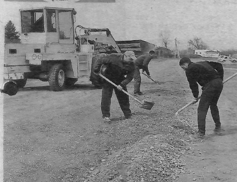
Дорожные работы ведут «ноевцы».
