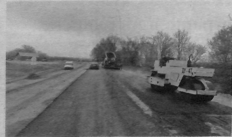
Укладка первого слоя асфальта. Фото с сайта администрации.
