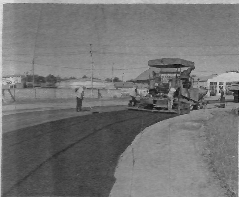
Укладка асфальтобетонного покрытия по пер. Пролетарскому.
