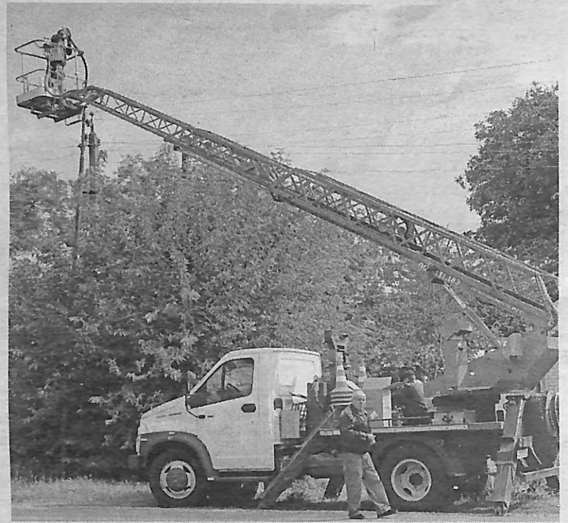
Установка уличных светильников по пер. Школьному райцентра.
