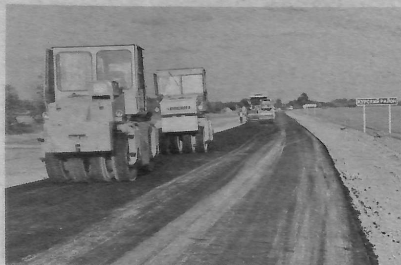
Участок региональной дороги «Стодеревская – Серноводское – Уваровское». Фото предоставлено Русским теротделом.
