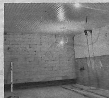
Работы на объекте.
