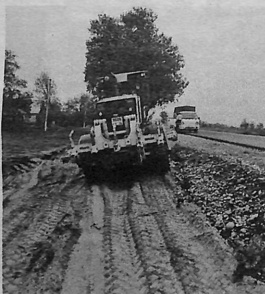
На Ставрополье к зиме подготовлено около 270 единиц дорожной спецтехники. Фото: миндор СК.
