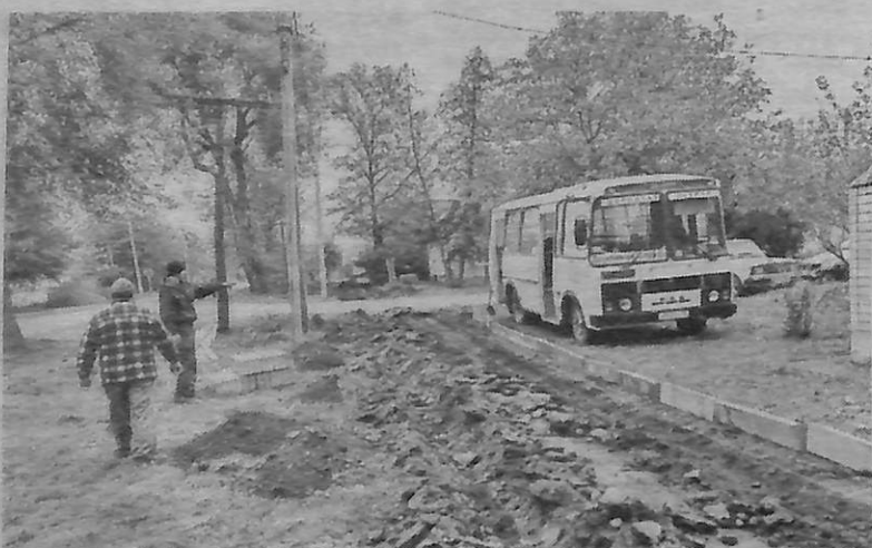
Дорожники заняты ремонтом участка дороги.
