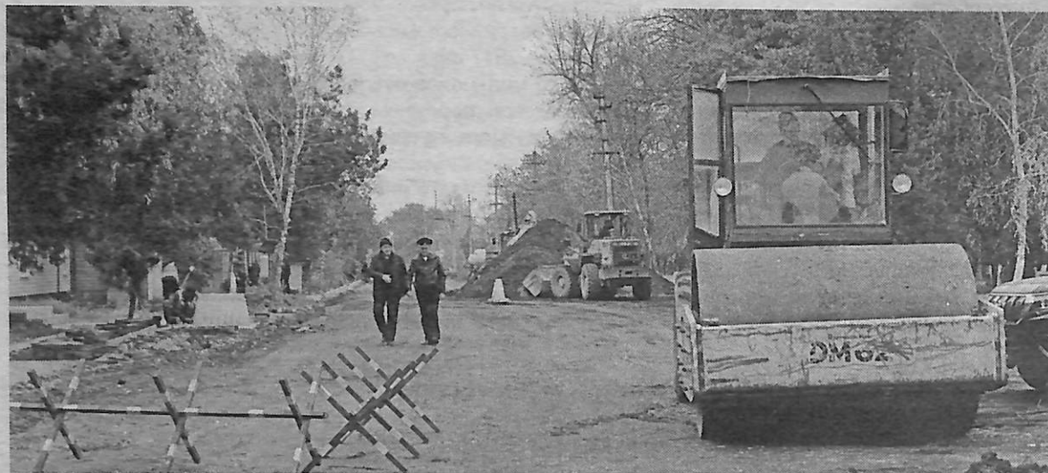
Ремонт ул. Акулова в ст. Курской. Фото автора.
