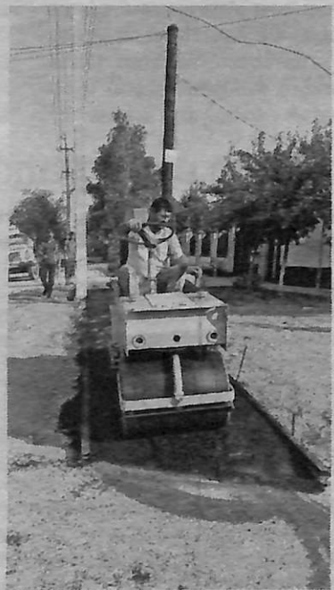
Укладка новых тротуаров.
