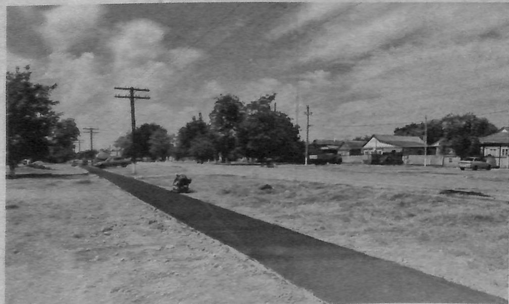
Новая тротуарная дорожка. Фото автора.
