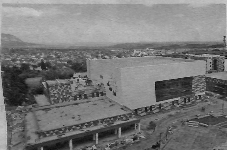
На объектах «Машука» проводят внутреннюю отделку помещений и благоустраивают прилегающую территорию.
