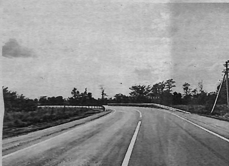
На Ставрополье в этом году планируется обновить 4 моста и 6 участков автодорог регионального значения. Фото: миндор СК.
