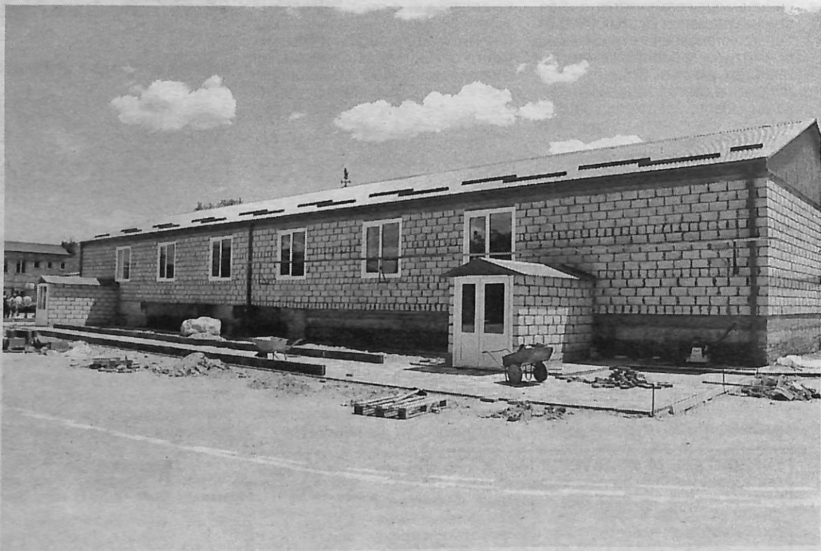
Будущий цех по производству мешков.
