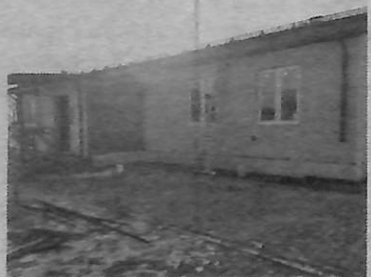
Строящийся объект здравоохранения в ст. Стодереvской.
