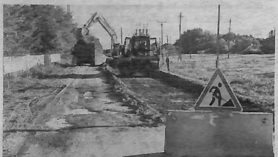
Демонтаж старого грунтового слоя. Фото автора.
