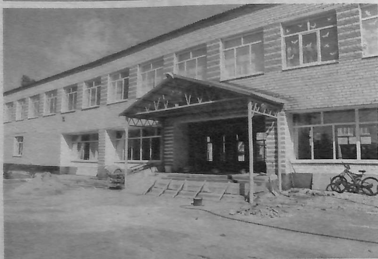
Идёт ремонт школы в с. Полтавское.
