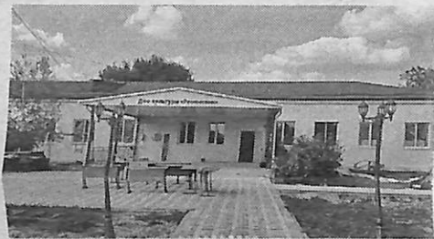
Благоустройство прилегающей территории к Дому культуры «Ремонтник».
