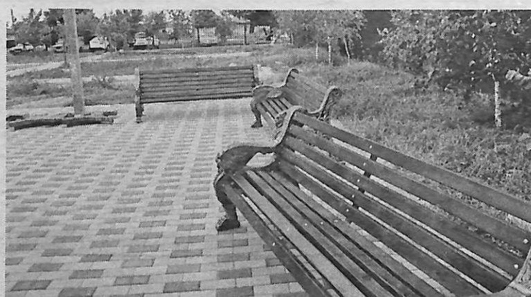
Монтаж лавочек в Доме культуры "Ремонтник"
