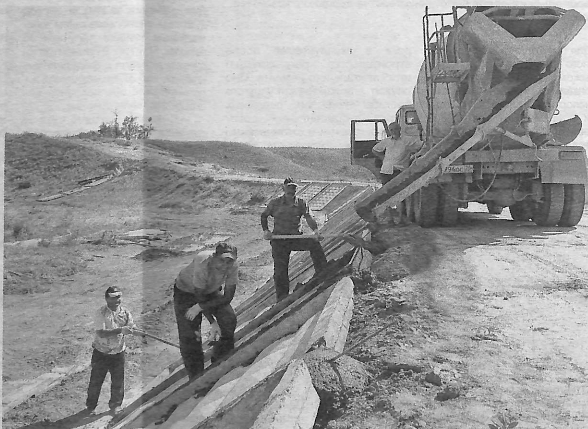
Процесс бетонирования дамбы
