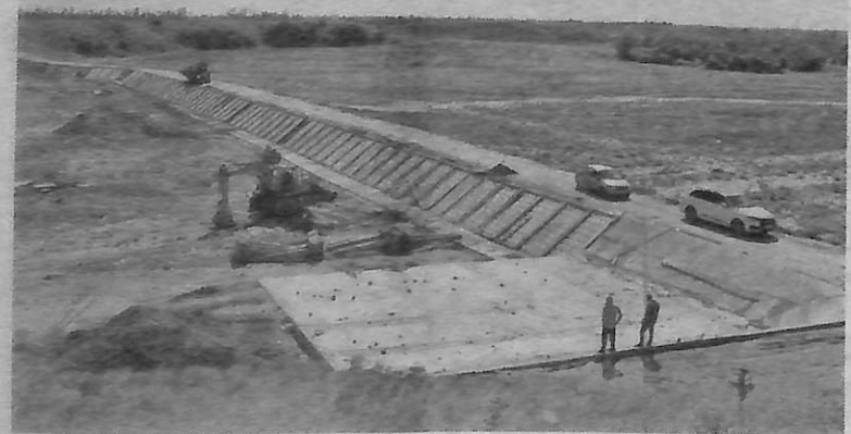
Общий вид строительства дамбы.
