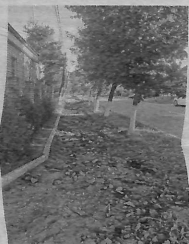
Ремонтные работы по ул. Моздокской.
