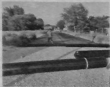
Ремонт дороги по улице Балтийской.
