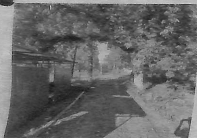
Ремонт тротуарной дорожки по ул. Акулова.
