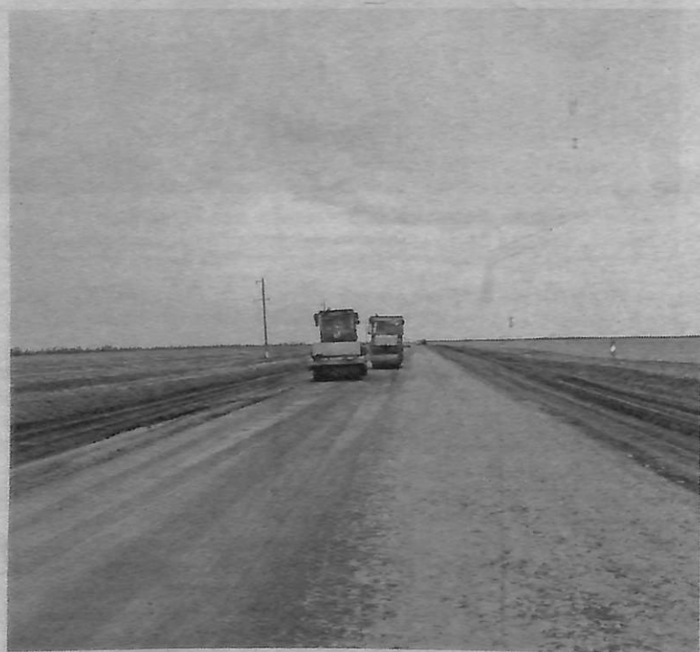
Дорожные работы ведёт Курский филиал ГБУ СК «Стававтодор».
