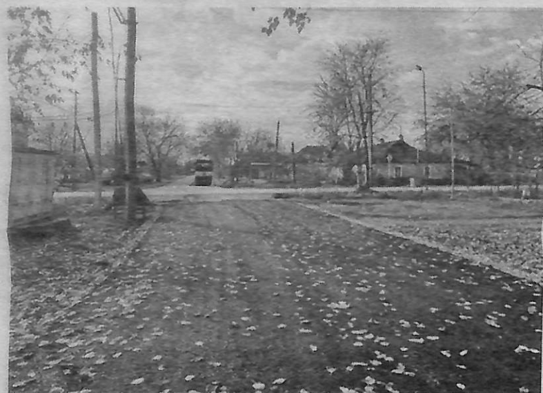
Ремонт ул. Интернациональной.
