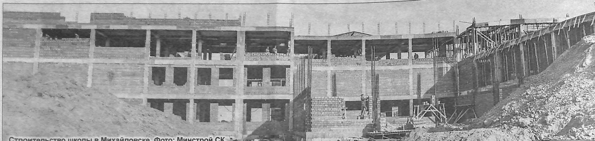
Строительство школы в Михайловске. Фото: Минстрой СК.
