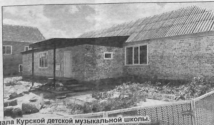
Идёт ремонт здания Эдиссийского филиала Курской детской музыкальной школы.
