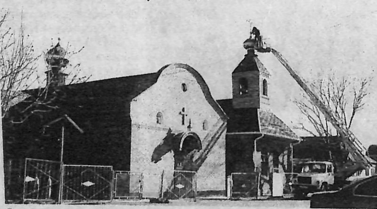
Строительство Крестильного храма и внешний ремонт основного здания церкви
