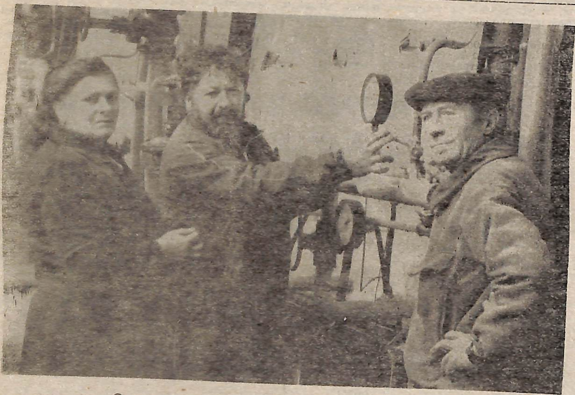
Операторы центральной котельной
