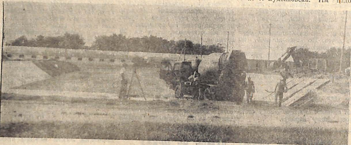
Строители ПМК-34 за работой.
